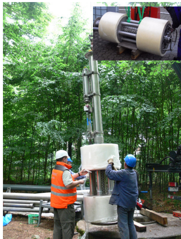
Abb. 2 Symmetrische Doppelkolbenkammer SDKK®-800.500 in Kombination mit am Förderrohr arretiertem hypop®-Prototyp und Standard-Version SDKK®-800.800 mit in der Kammer voll integriertem hypop®.
